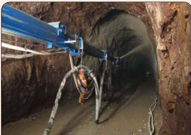
تونل انتقال آب خام پینه
