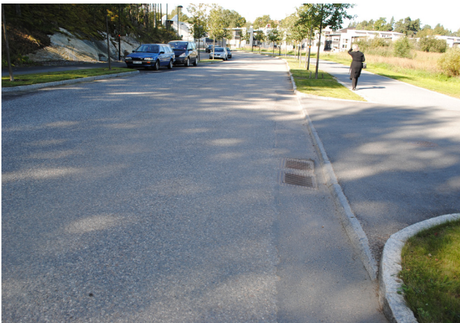
دریچه هدایت آبهای سطحی به لوله‌های فاضلاب شهری کنار خیابان - شیب کف خیابان به طرف دریچه‌ها می‌باشد.
