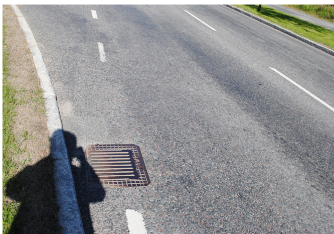
دریچه کنار خیابان که آب‌های سطحی خیابان طبق شیب خیابان و پیاده رو به آن هدایت می‌شوند.
