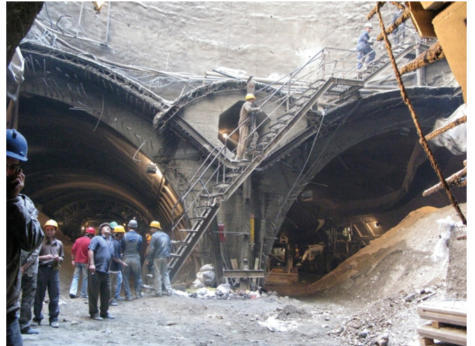
شکل ۸- عملیات اجرایی ساخت تونل
