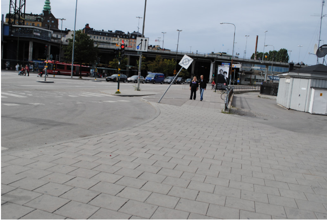
پیاده روسازی با شیب به طرف کف خیابان. سنگ جدول برای سهولت عبور عابر پیاده از خیابان در این محل تقریباً با کف خیابان هم‌تراز است.
