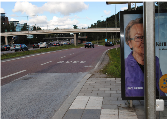
محل ایستگاه اتوبوس، آسفالت کف خیابان در محل ایستگاه اتوبوس رنگی است.
