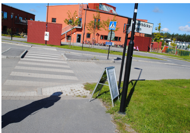
محل عبور عابر پیاده از عرض خیابان. برای سهولت عبور عابرین پیاده، معلولین و کالسکه کودکان، کف پیاده با کف خیابان هم تراز است.
