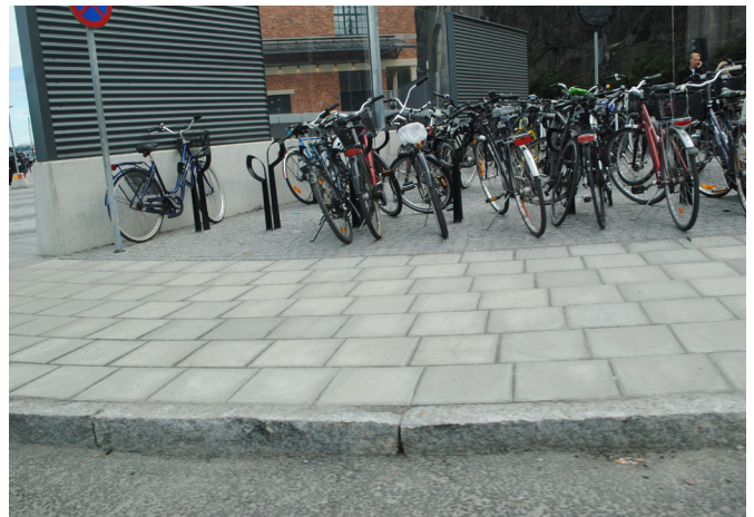
جدول کنار خیابان از سنگ گرانیت پایدار و با ابعاد استاندارد.
