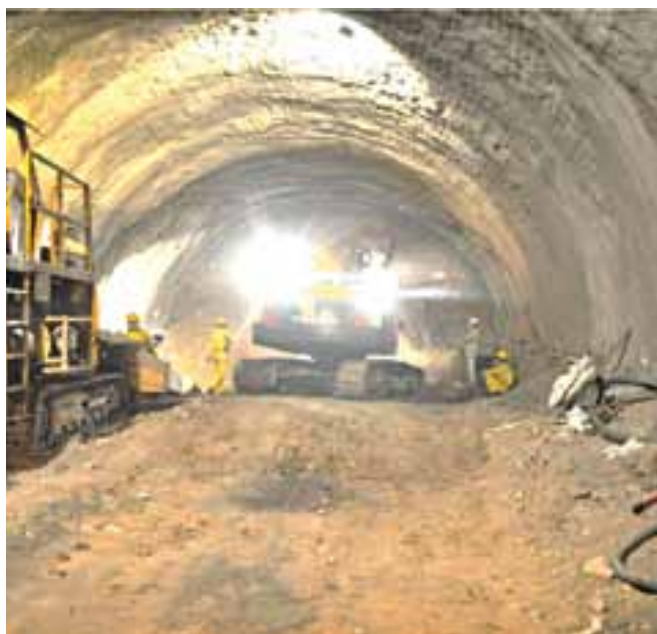
حفاری تونل دسترسی جنوبی - کارگاه نونهالان
