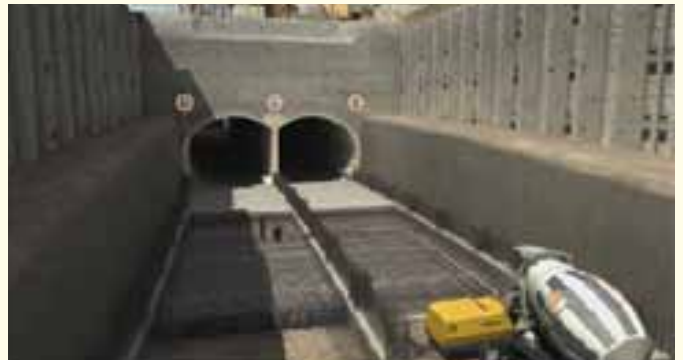
شکل ۲۴- بتن‌ریزی کف T۲ بعد از اتمام خاک‌برداری
