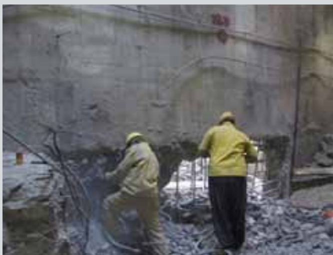
شکل ۹- تخریب فونداسیون دیوارهای قبلی
