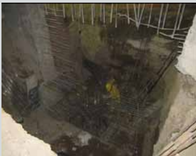
شکل ۱۰- اجرای شمع‌های زیر دیوار
