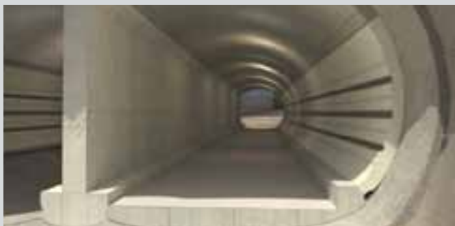
شکل ۱۶- وضعیت تونل بعد از اجرای لاینینگ
