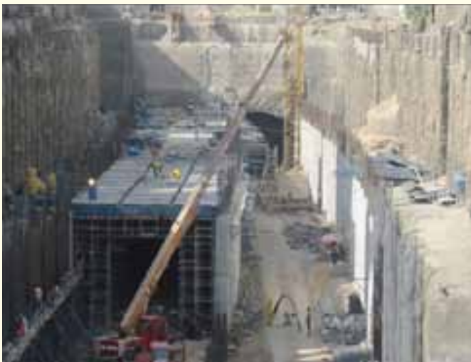
شکل ۲۹- نمایی از عملیات اجرایی در بخش T۲
