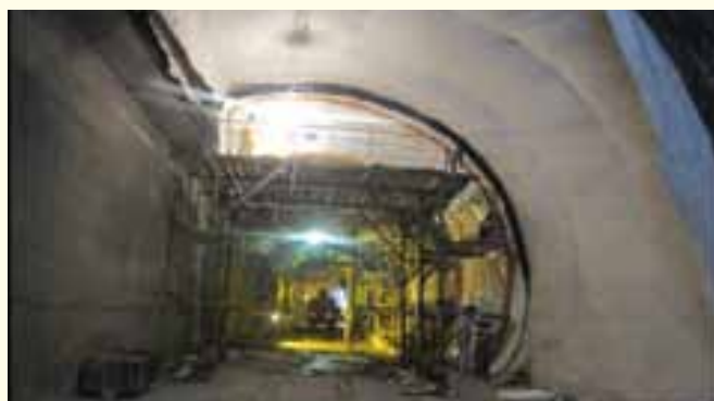
شکل ۱۹- عملیات اجرایی واترپروفینگ تونل TU
