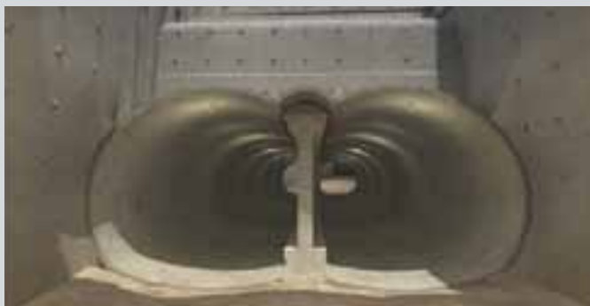
شکل ۱۵- وضعیت تونل بعد از اتمام حفاری
