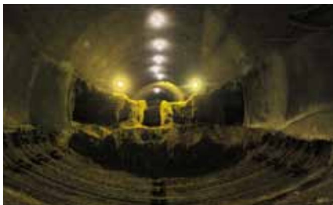
شکل ۳۷- اجرای حفاری در تونل T۴
