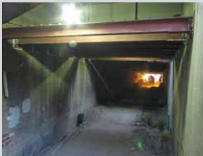
شکل ۶- نمای کلی از مسیر شمالی بخش T۱
