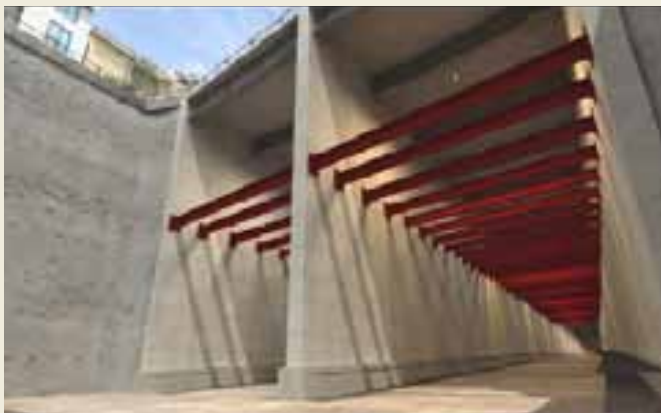
دهانه شرقی زیرگذر امیر کبیر بعد از انجام عملیات اجرایی کف زیرگذر و نصب استرات‌های فوقانی
