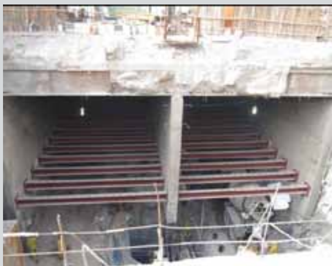
شکل ۷- نمایی از دهانه شرقی T۱- قبل از بتن‌ریزی دال سقف
