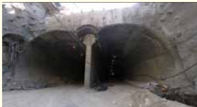
شکل ۱۸- عملیات اجرایی واترپروفینگ تونل TU
