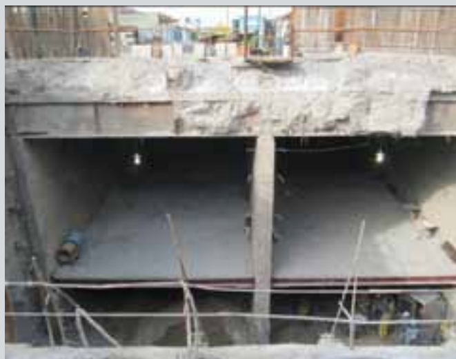
شکل ۸- نمایی از دهانه شرقی T۱- بتن‌ریزی دال سقف
