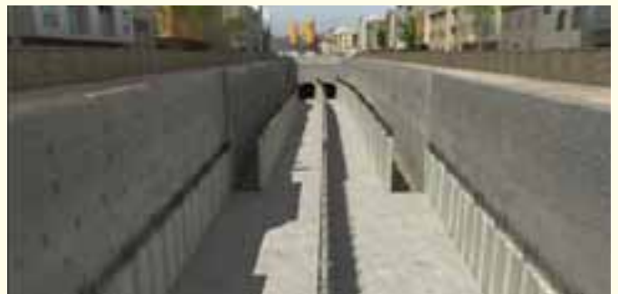
شکل ۲۵- احداث دیوارهای زیرگذر
