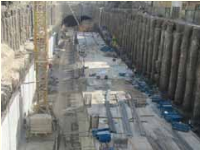
شکل ۲۸- نمایی از عملیات اجرایی در بخش T۲
