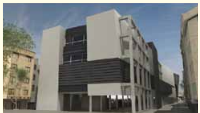
شکل ۲۷- نمایی از مجتمع تجاری
