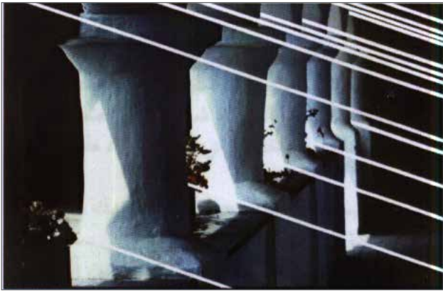
شکل ۲۰. خطوط سفید توصیف گرافیکی تابش ضعیف خورشید در زمستان در حالی که خطوط سایه‌دار روی ستون‌ها نشانگر تأثیر حفاظتی آن در برابر تابش شدید خورشید در تابستان است.
