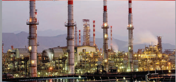
Bandar Abbas Refinery, Location: Bandar Abbas, Hormozgan پالایشگاه بندر عباس
