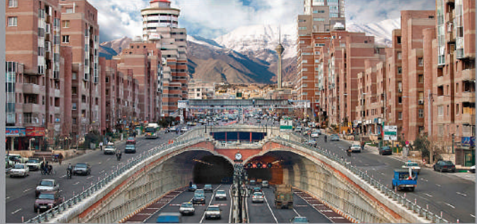
Toheed Tunnels Project, Location: Tehran پروژه تونل توحید
