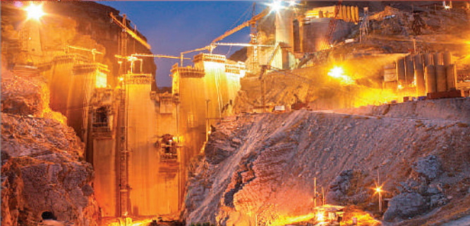
Seymareh Dam & Hydroelectric Power Plant Project, Location: Seymareh - Ilam پروژه سد و نیروگاه سیمره
