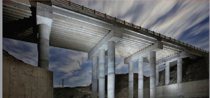
Main Road of Chabahar, Nik-Shahi, Iran-Shahr Project, Sections 5 and 6, Location: Chabahar پروژه قطعات ۵ و ۶ راه اصلی چابهار - نیکشهر - ایرانشهر
