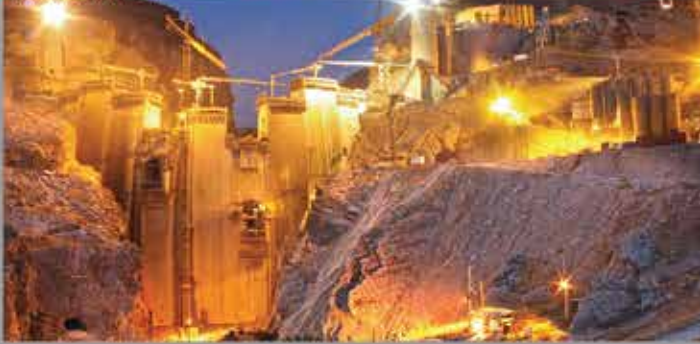
پروژه سد و نیروگاه سبزو Seymareh Dam & Hydroelectric Power Plant Project Location: Seymareh Dam
