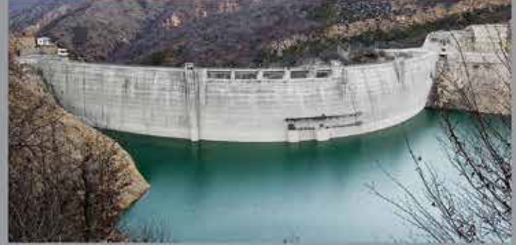
پروژه سد شهید رجایی (سازمان خاکی) Shahid Rajee (Tajiri) Dam Project Location: Sari-Mazandaran
